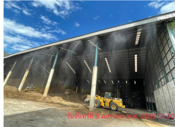
รูปที่ 19 อาคารเก็บกากอ้อยและสเปรย์น้ำ
