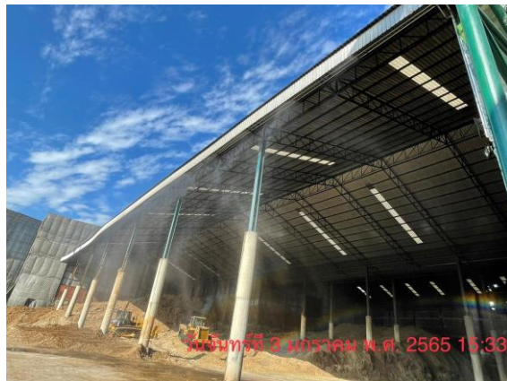
รูปที่ 19 อาคารเก็บกากอ้อยและสเปรย์น้ำ
