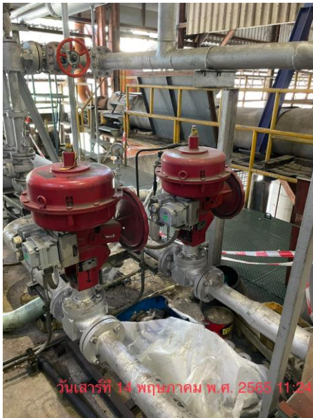
รูปที่ 68 Control Valve
