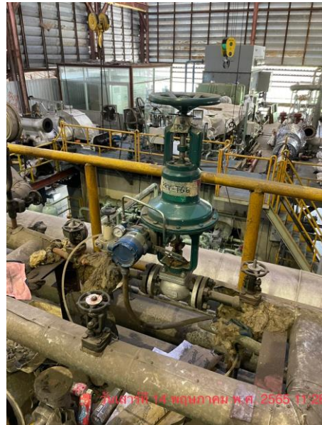
รูปที่ 69 Bypass Valve
