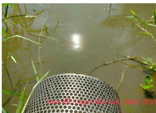
รูปที่ 42 ตะแกรงปลายท่อสูบน้ำ
