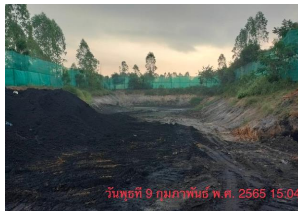
รูปที่ 57 ค้นดินและแนวกันฝุ่น บริเวณรอบบ่อเถ้า
